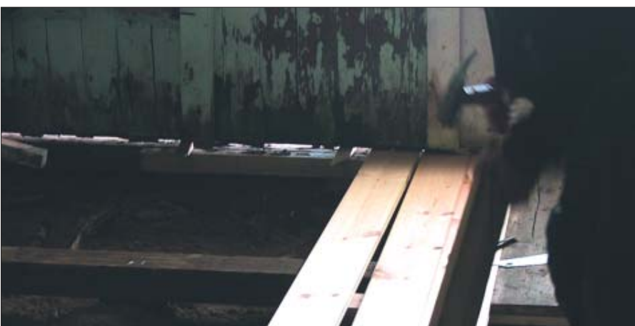
Gulvet går ud under væggen og færdigt gulv.
