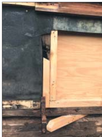
T.v. og i midten: De rådne stolper under vinduet. T.h. Det nye tømmer gasbrændes for at give det et autentisk udseende.
