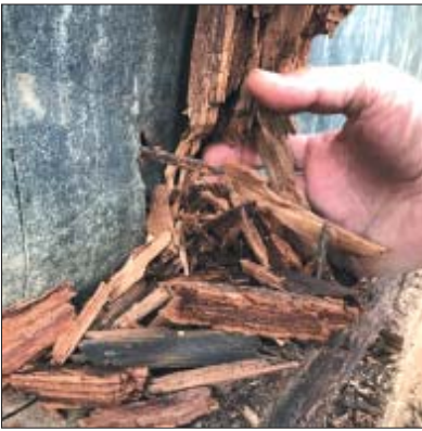
Udgravningen langs væggene afslørede mere og mere råddent træ, som stort set smuldrede væk mellem fingrene.
