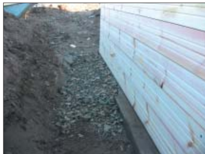
Den ny væg med gulvbrædder, dræn af skærver og tagpap.
