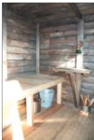
Renovering af Blæsenborg [443]. Det gamle gulv var råddent og måtte skiftes. Indenfor blev der lavet en ny buf og et bord i stil med det tidligere.
