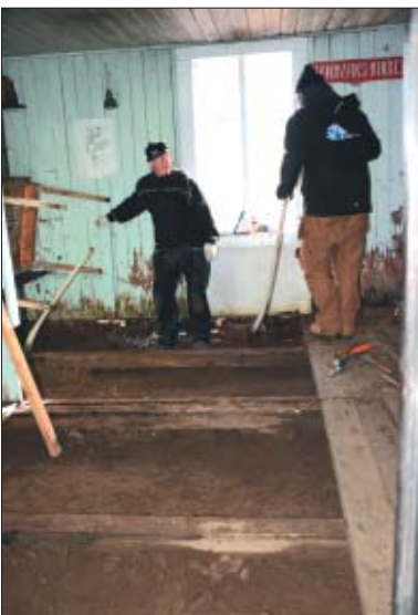
Gulvbjælkerne graves fri i den del af gulvet, der er brækket op. Mange af plankerne smuldrer.
