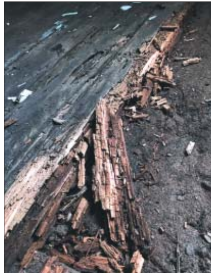
Gulvbjælkerne graves fri i den del af gulvet, der er brækket op. Mange af plankerne smuldrer.
