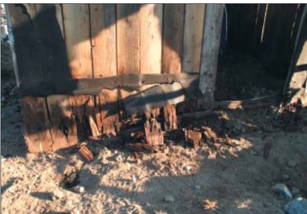
Renovering af Antonsens hytte [444] i Store Sødal. Øverst: Hytten ved ankomsten. De nederste 15-30 cm af væggene var rådne. Hjørnebrædderne og brædderne ved døren blev skiftet, så de kunne bære hytten.
