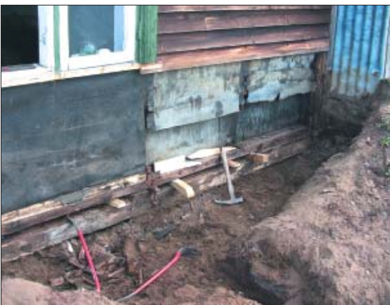
T.v. og i midten: De rådne stolper under vinduet. T.h. Det nye tømmer gasbrændes for at give det et autentisk udseende.
