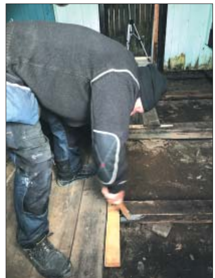
Gulvbjælkerne graves fri i den del af gulvet, der er brækket op. Mange af plankerne smuldrer.
