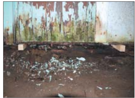
Udgravningen langs væggene afslørede mere og mere råddent træ, som stort set smuldrede væk mellem fingrene.
