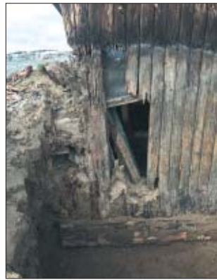
Udgravningen langs væggene afslørede mere og mere råddent træ, som stort set smuldrede væk mellem fingrene.
