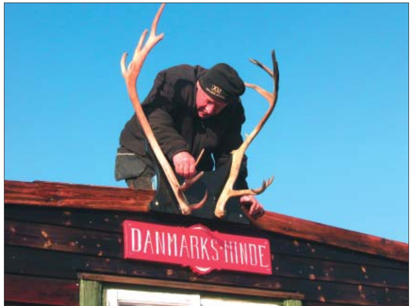
Geviret repareres og monteres.
