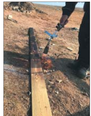
T.v. og i midten: De rådne stolper under vinduet. T.h. Det nye tømmer gasbrændes for at give det et autentisk udseende.
