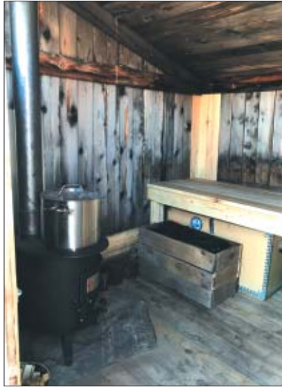
Antonsens hytte [444] efter renovering. Den gamle ovn stod på en flad sten på 1/2 m 2 og resten af gulvet bestod af jord og sten. Vi valgte at lægge et trægulv og fik placeret stenen, så den nye ovn også kom til at stå på den.
