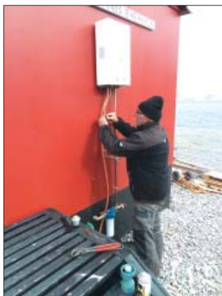
T.v. Installering af vandvarmer til Tolvmandsbarakken. I midten: Montering af køleskab og komfur. T.h. Rindende varmt og koldt vand gør køkkenarbejdet meget lettere.
