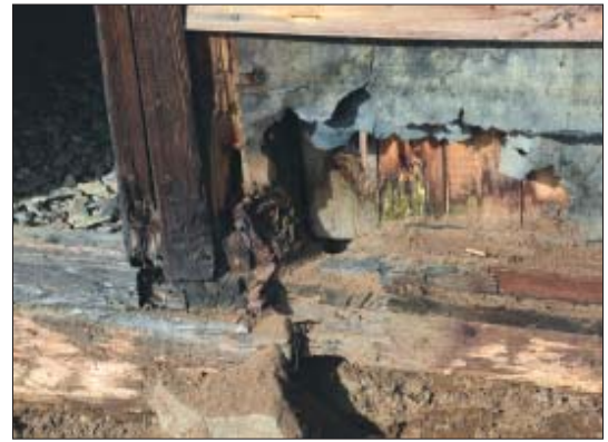
Udgravningen langs væggene afslørede mere og mere råddent træ, som stort set smuldrede væk mellem fingrene.
