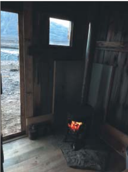
Antonsens hytte [444] efter renovering. Den gamle ovn stod på en flad sten på 1/2 m 2 og resten af gulvet bestod af jord og sten. Vi valgte at lægge et trægulv og fik placeret stenen, så den nye ovn også kom til at stå på den.
