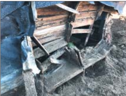
Udgravningen langs væggene afslørede mere og mere råddent træ, som stort set smuldrede væk mellem fingrene.
