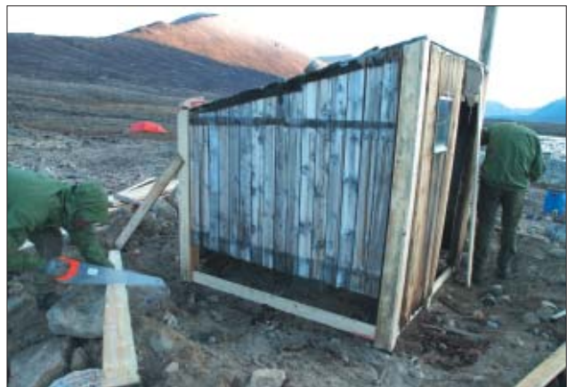
Renovering af Antonsens hytte [444] i Store Sødal. Øverst: Hytten ved ankomsten. De nederste 15-30 cm af væggene var rådne. Hjørnebrædderne og brædderne ved døren blev skiftet, så de kunne bære hytten.
